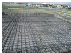
基礎鉄筋強化(150間隔)
