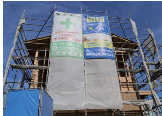
構造見学会が行われる建築中の二世帯住宅。梁や柱などの構造材や断熱の様子を見ることができる
