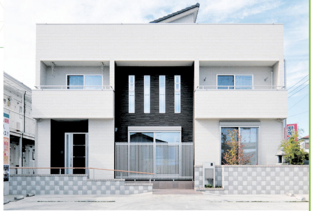
約6坪の太陽光発電パネルを搭載した省エネ性能の高いゼロエネ住宅
