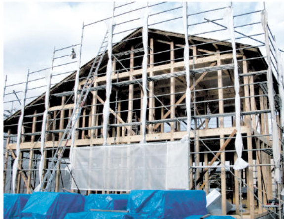
前橋市山王町に建築中のモデルハウス。介護のしやすい二世帯住宅になっている
