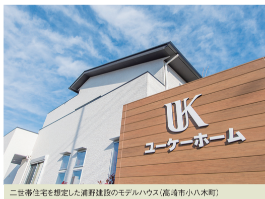
二世帯住宅を想定した浦野建設のモデルハウス(高崎市小八木町)
