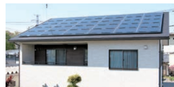
屋根に搭載したLIXILの太陽光発電パネル
